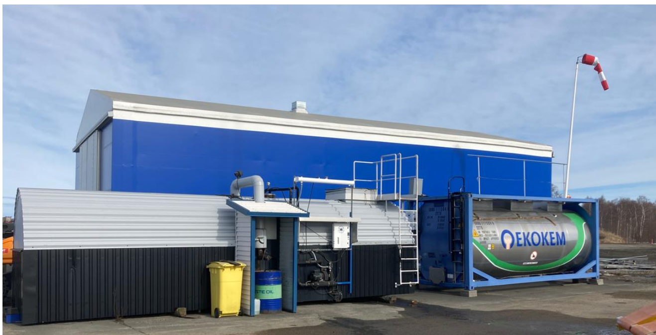
Öljypitoisten jätteiden välivarasto.
